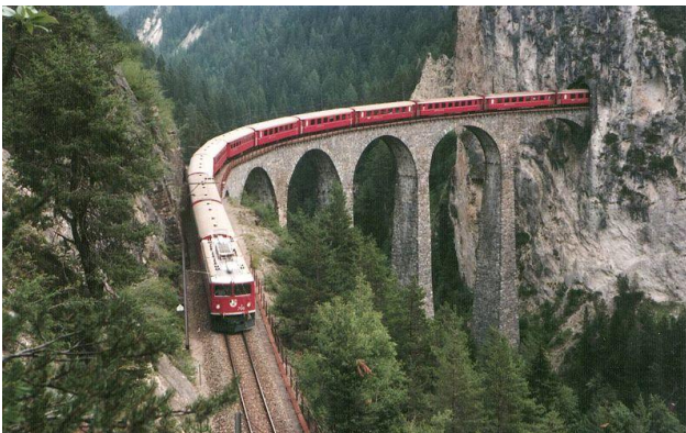
Landwasserviadukt der RhB
